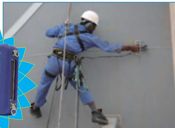
储罐焊缝手动TOFD检测
