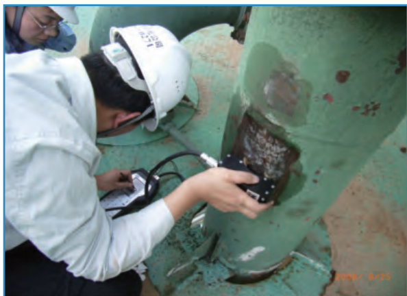
手动管道局部腐蚀检测
