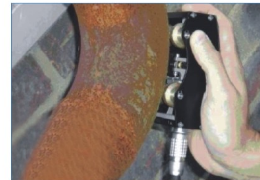
滚动干耦合扫描器弯管腐蚀检测
