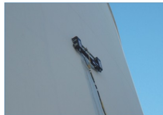
机器人爬行器大型储罐腐蚀检测
