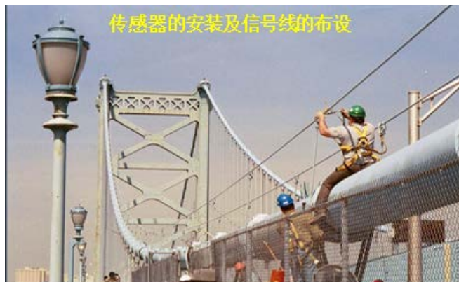
悬索桥/斜拉桥的钢筋断裂监测
