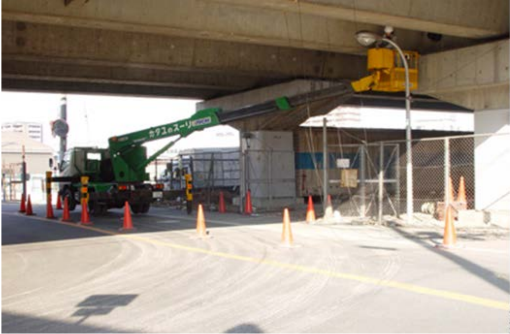
混凝土桥的裂纹及腐蚀监测
