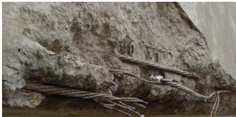
混凝土桥梁或水泥板的可见/不可见裂纹及腐蚀
