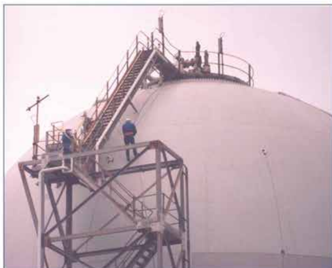
锅/特检/石油石化
