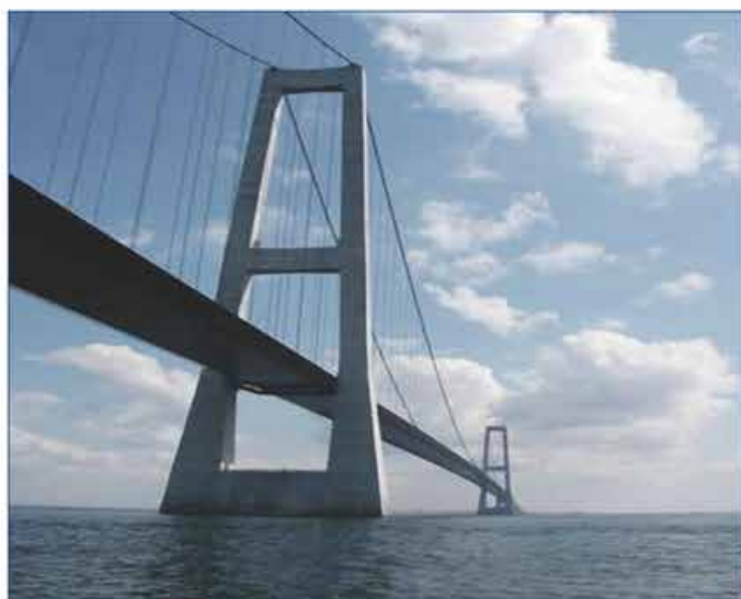
桥梁/岩石/混凝土
