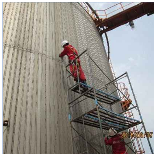
常压储罐声发射监测
