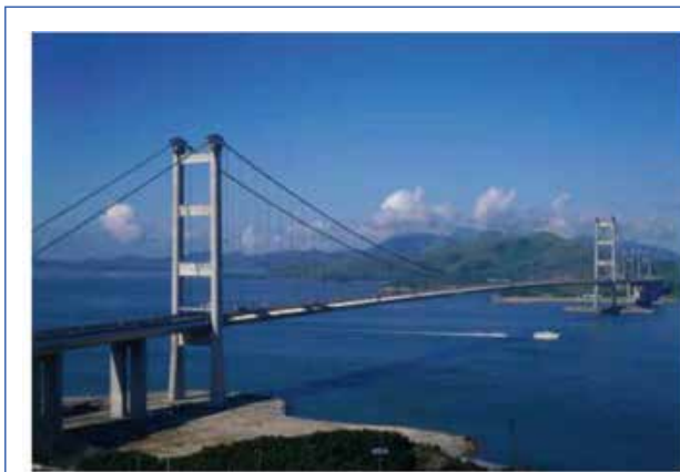
桥梁缆索断丝监测
