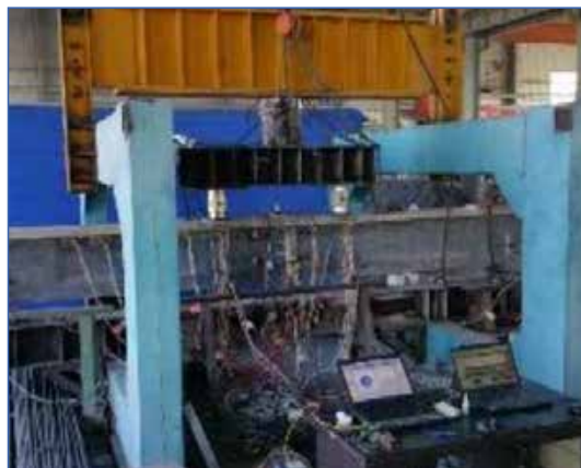
RPC混凝土三点弯曲静载监测
